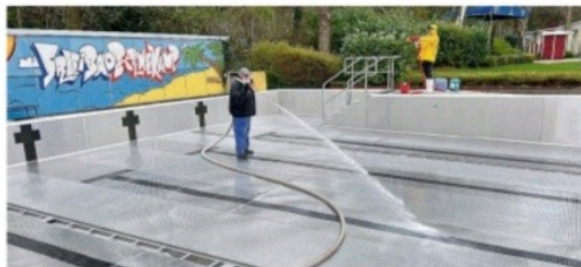
Im Winter bleibt das Wasser immer im Becken. Im Frühling wird abgelassen für die Reinigungsaktion. Das Befüllen dauert dann immer rund zweieinhalb Tage.
